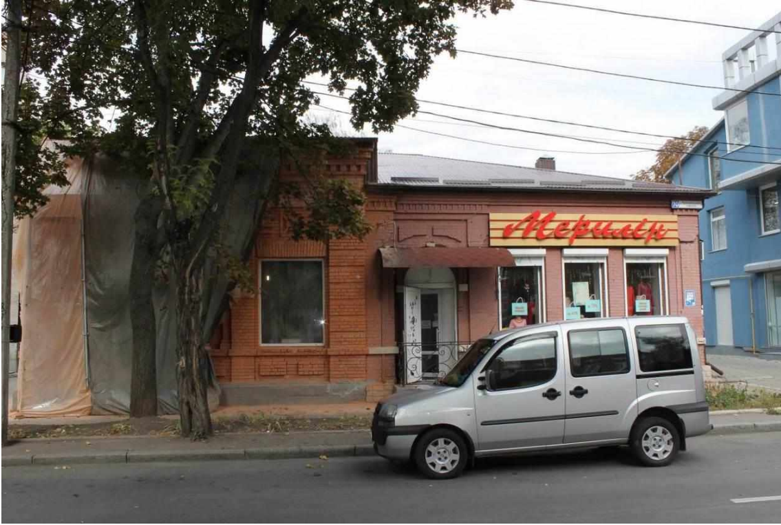
119. Будинок житловий, кін. XIX ст., вул. Проскурівського підпілля, 70. Фото жовтень 2016 р. Щойно виявлений об'єкт культурної спадщини за видом архітектури.
