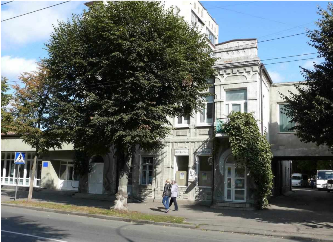
111. Будинок прибутковий, поч. ХХ ст., вул. Проскурівська, 67. Фото жовтень 2016 р.
