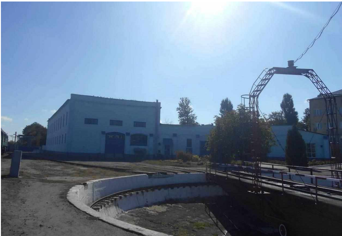
4. Комплекс будівель вагонного депо. Механічний корпус, 1910-ті рр., вул. Волочиська, 10. Фото жовтень 2016 р.
