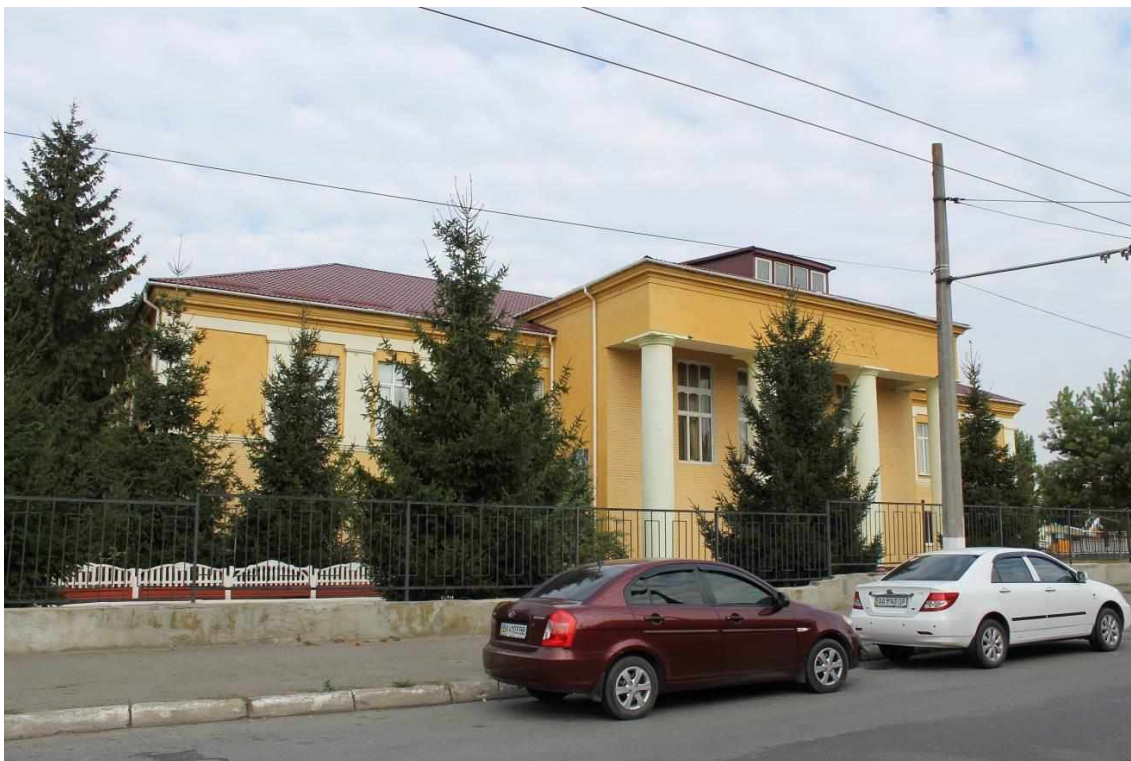
25. Будівля штабу. 1936 р., вул. Горького. Фото жовтень 2016 р.
