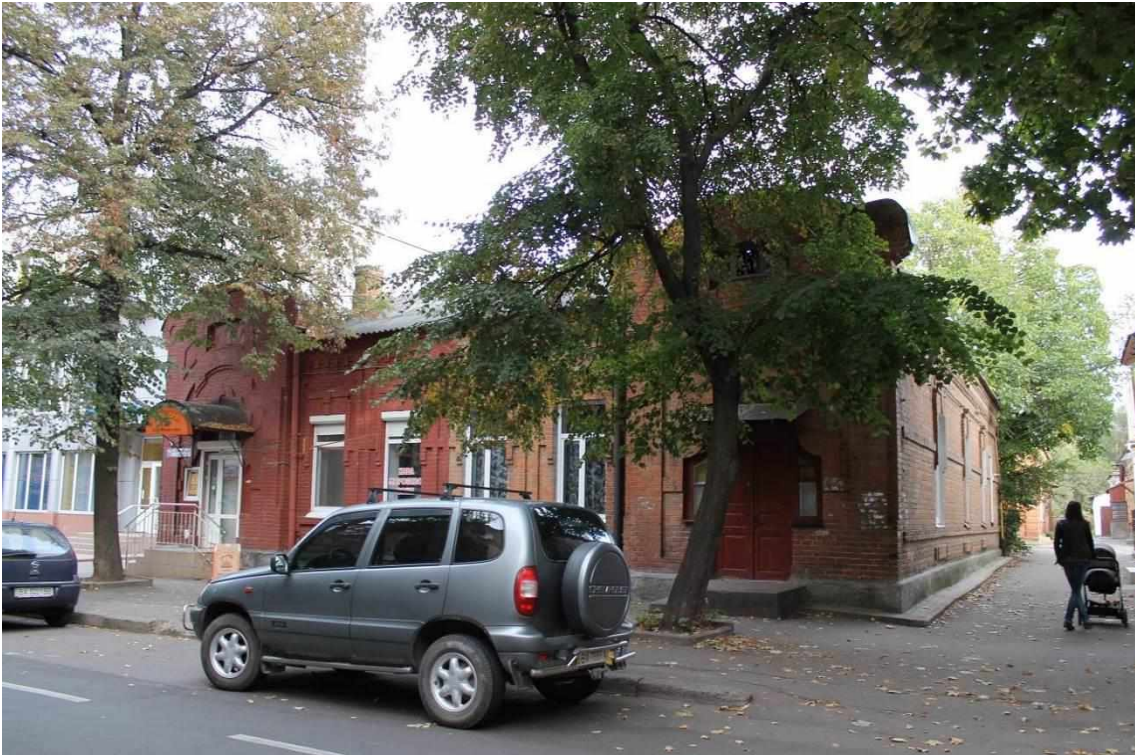
120. Будинок житловий, кін. XIX ст., вул. Проскурівського підпілля, 75. Фото жовтень 2016 р. Щойно виявлений об'єкт культурної спадщини за видом архітектури.
