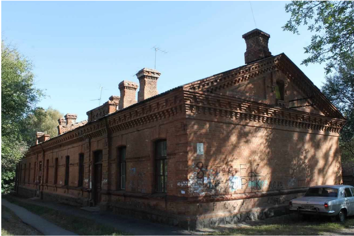
27. Будинок житловий, 1890-ті рр., вул. Гастелло, 8. Фото жовтень 2016 р.
