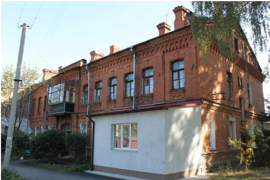
28. Будинок житловий, 1890-ті рр., вул. Гастелло, 10. Фото жовтень 2016 р.
