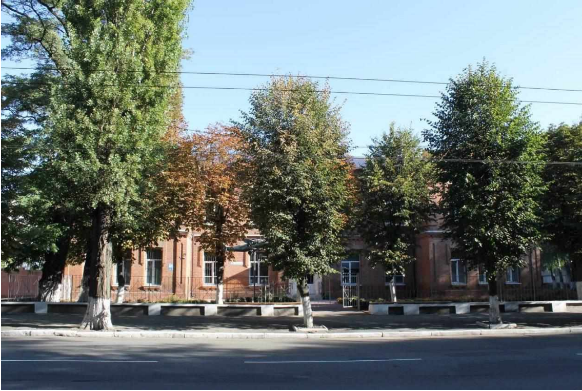
115. Будівля Міського училища, 1906 р., вул. Проскурівська, 83. Фото жовтень 2016 р. Щойно виявлений об'єкт культурної спадщини за видом архітектури.
