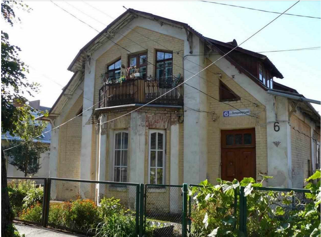
15. Будинок житловий кварталу із типових котеджів, 1920-ті рр., пров. Володимирський, 6. Фото жовтень 2016 р. Щойно виявлений об'єкт культурної спадщини за видом архітектури.
