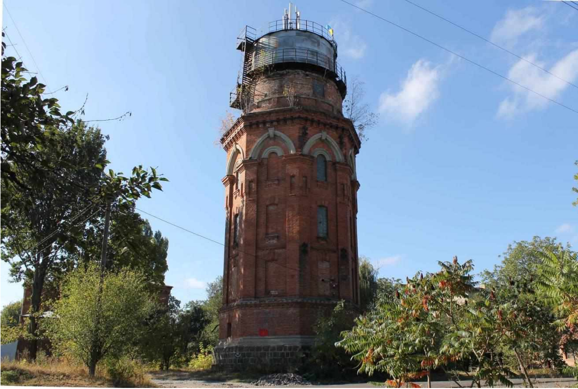
23. Водонапірна вежа, 1910 р., вул. Гастелло. Фото жовтень 2016 р. Щойно виявлений об'єкт культурної спадщини за видом архітектури.
