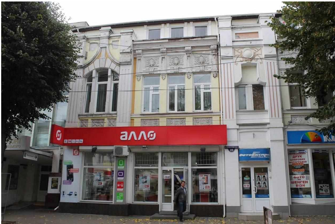
98. Будинок прибутковий, поч. ХХ ст., вул. Проскурівська, 28. Фото жовтень 2016 р. Щойно виявлений об'єкт культурної спадщини за видом архітектури.
