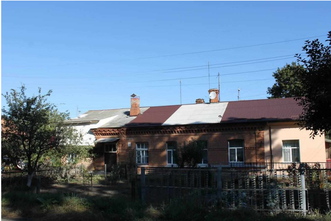
25. Будинок житловий, 1890-ті рр., вул. Гастелло, 4. Фото жовтень 2016 р.
