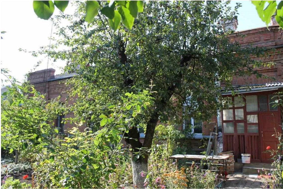
127. Будинок житловий, 1890-ті рр., вул. Юхима Сіцинського, 4. Фото жовтень 2016 р. Щойно виявлений об'єкт культурної спадщини за видом архітектури.
