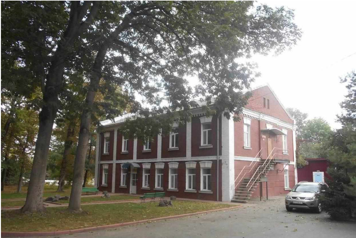
39. Комплекс будівель пивоварного заводу Кляве. Корпус адміністративний, 1901 р., вул. Чорновола, 24. Фото жовтень 2016 р.
