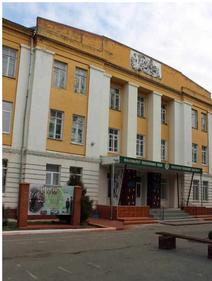
21. Військове містечко танкової бригади. Будинок житловий. Фрагмент головного фасаду. 1936 р., вул. Проскурівська, 89. Фото жовтень 2016 р.
