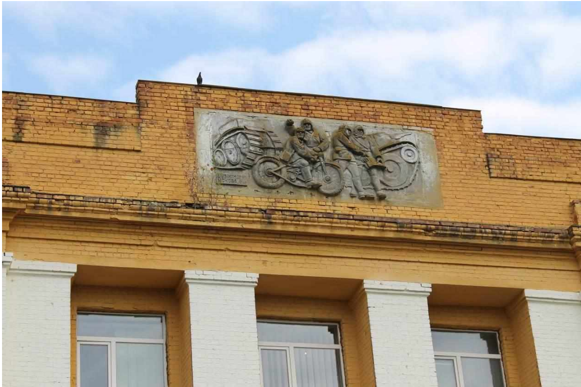
23. Військове містечко танкової бригади. Будинок житловий. Фрагмент головного фасаду. 1936 р., вул. Проскурівська, 93. Фото жовтень 2016 р.
