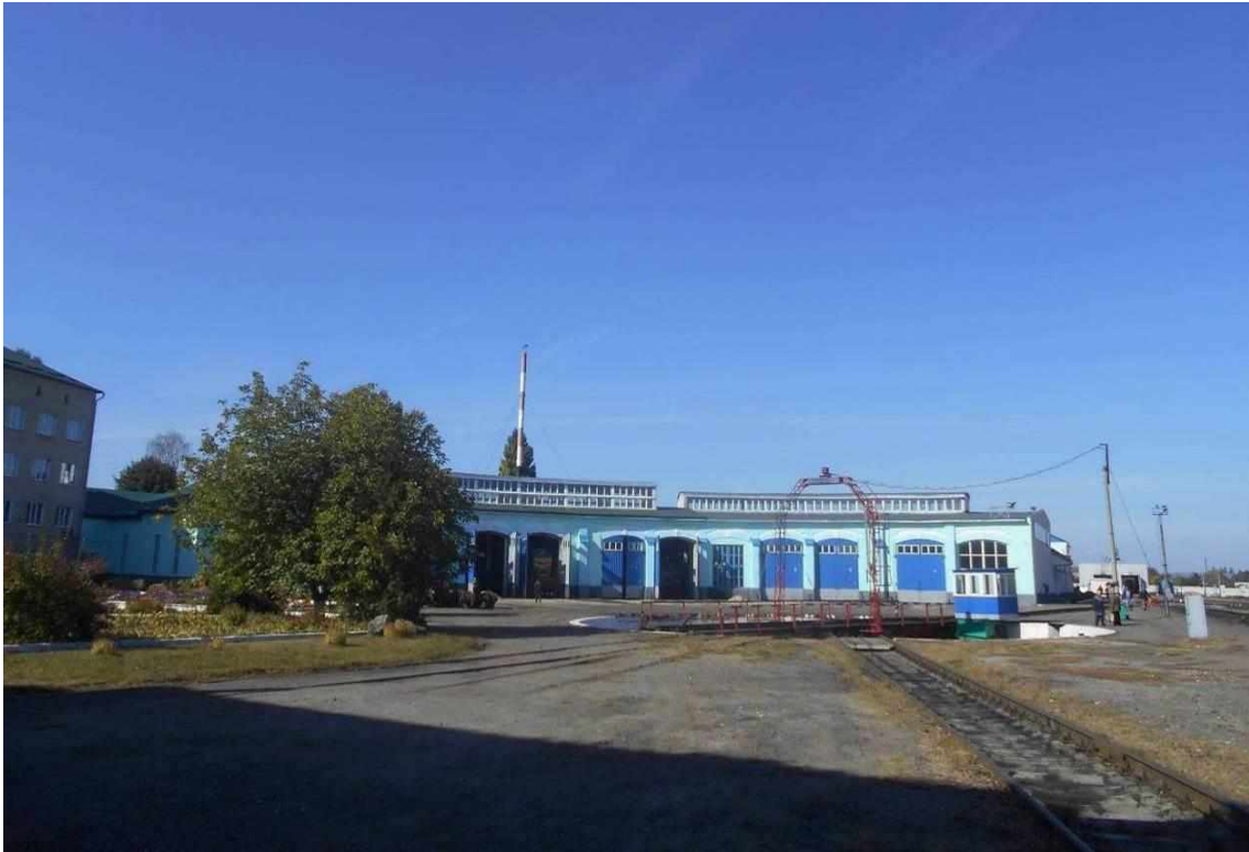
3. Комплекс будівель вагонного депо. Механічний корпус, 1910-ті рр., вул. Волочиська, 10. Фото жовтень 2016 р.
