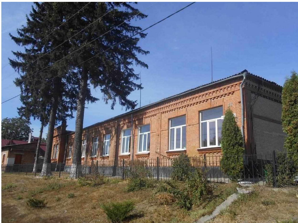
29. Будівля церковно-парафіяльної школи, поч. XX ст., вул. Профспілкова, 39. Фото жовтень 2016 р.
